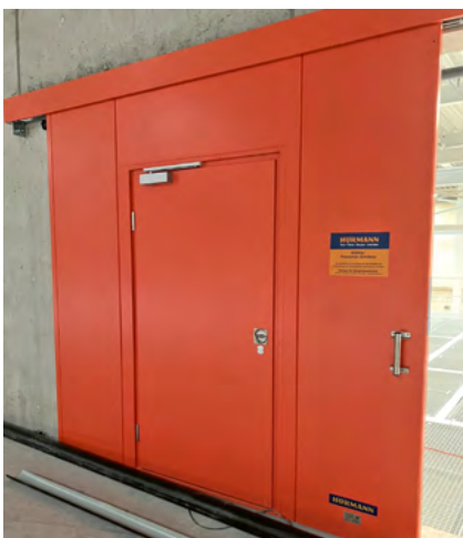
Brandschutztor mit Schlupftüre.
