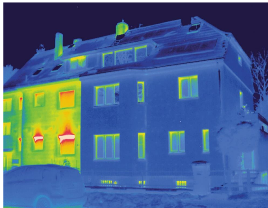
Deutlich zu erkennen: eine gedämmte und ungedämmte Aussenwand an einem Mehrfamilienhaus.
