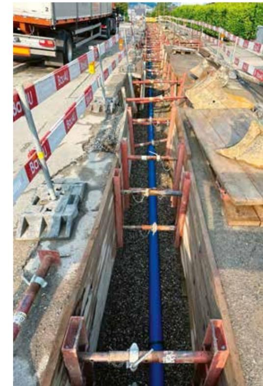
Die neu im Graben verlegte Wasserleitung GD 125, im Kies eingebettet. Die neue Wasserleitung befindet sich im östlichen Teil des Simon-Gfellerwegs. (Foto: zVg)
