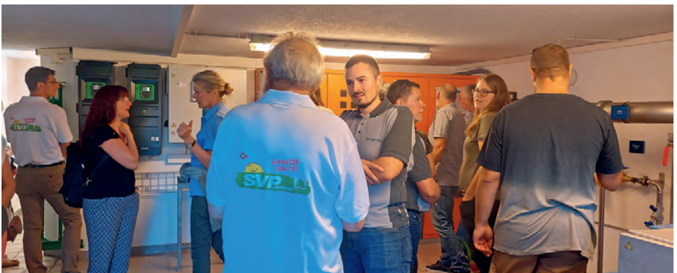
Spannende Einblicke in das Pumpwerk am Quellgässli.
