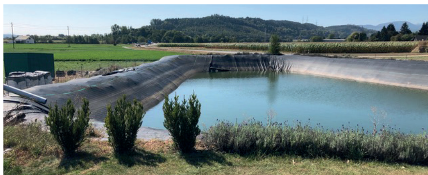
Abb. 3 Regenwasser-Speicherbecken zur Bewässerung der Treibhäuser © ecoptima
