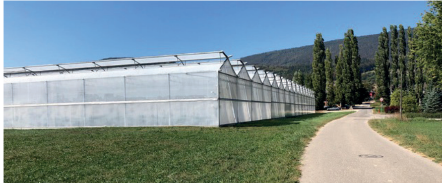
Abb. 4 Kompakte Treibhausanlage auf ebenem, gegen Süden leicht angeschüttetem Terrain, im Norden leicht eingegraben; rechts davon der Eyweg, ein Rad- und Güterweg, der auf den Kreisel der Kantonsstrassen führt und das Areal erschliesst. © ecoptima
