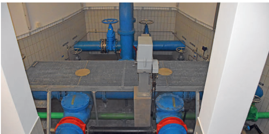
Der Rohrkeller im wesentlich neuen Reservoir West macht einen «frischeren» Eindruck als derjenige im Reservoir Ost.
