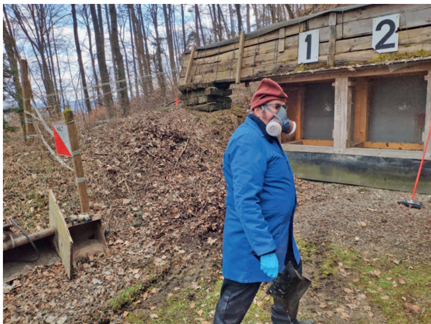
Der Altkugelfang wurde unter strengen Vorsichtsmassnahmen demontiert.
