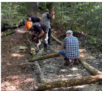
Die neue Konstruktion nimmt Formen an.
