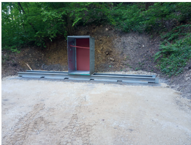
Ein Unterbau für den neuen Kugelfang.
