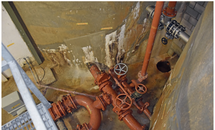
Blick auf den in die Jahre gekommenen Rohrkeller des Reservoirs Ost.
