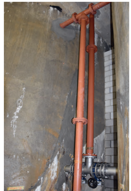
Verrohrung der beiden Wasserkammern im Reservoir Ost.
