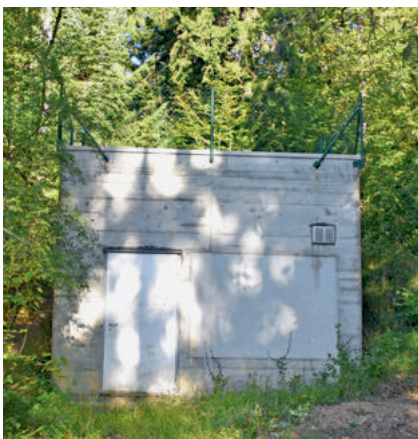
Das älteste der drei Wasserreservoirs in der Gemeinde wurde 1908 erbaut und muss ersetzt werden.
