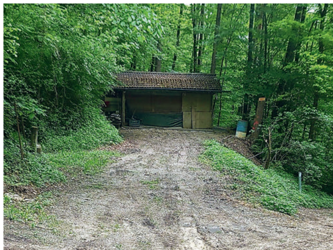
Die Umgebungsarbeiten des Schützenhauses dauern noch an.
