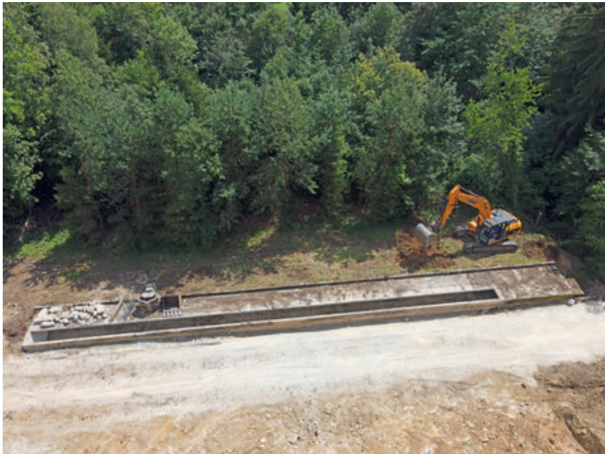
Ende Juli 2020 begannen die Sanierungsarbeiten bei der alten Schiessanlage Grot, weil die Böden hinter den Zielscheiben stark mit Blei kontaminiert waren.
