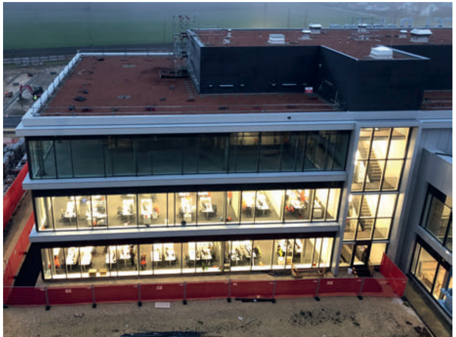
Aussenansicht des Administrationsgebäudes (GLA).
