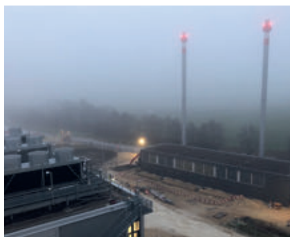
Die beiden Kamine der Notstromanlage im Nebel.
