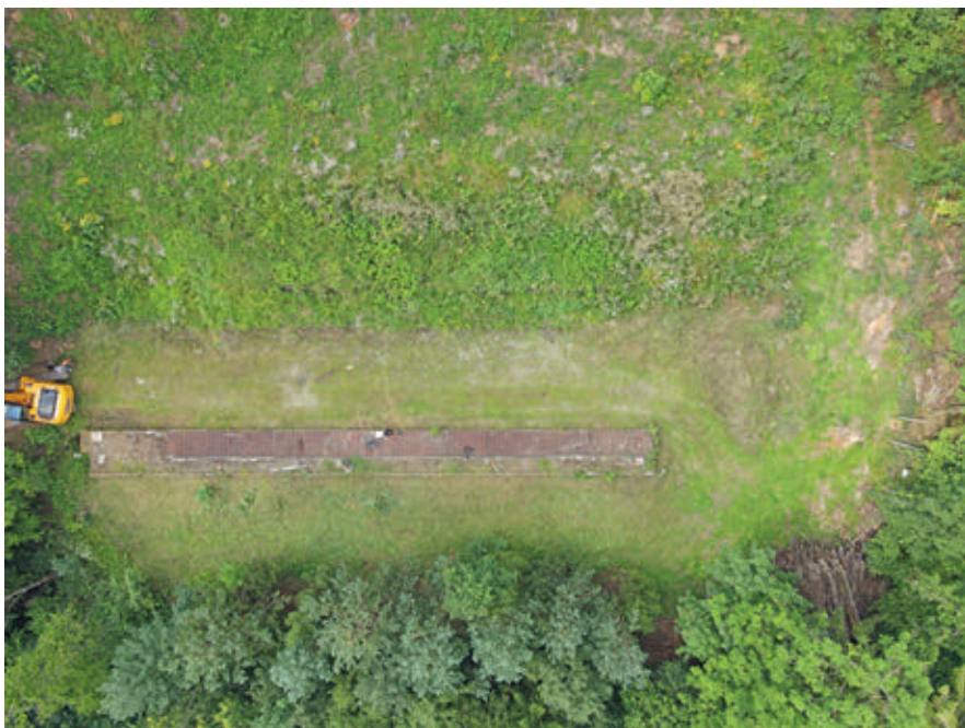
Rund um die Schiessanlage hatte sich die Goldrute angesiedelt, ein Neophyt der ebenfalls fachgerecht entsorgt werden musste.
